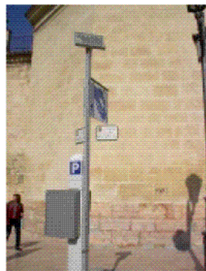
Parkimetro con placa solar
